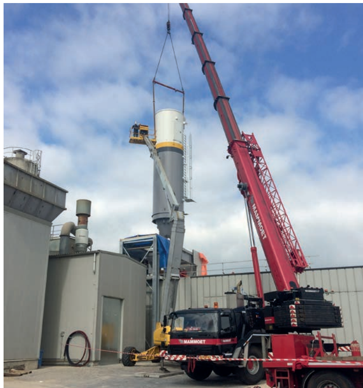
Afb. 2 De installatie van de silo bij Remix Droge Mortel
